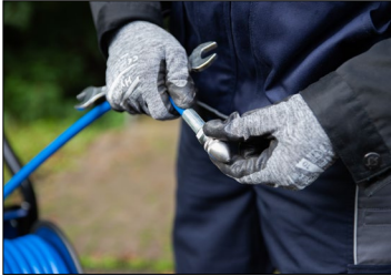
Abb. 8: Aufschrauben der Rohrreinigungsdüse
